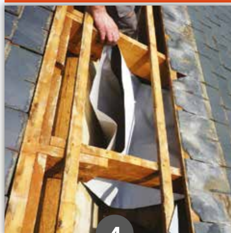
INSERTION DES SACS ENTRE LES CHEVRONS
