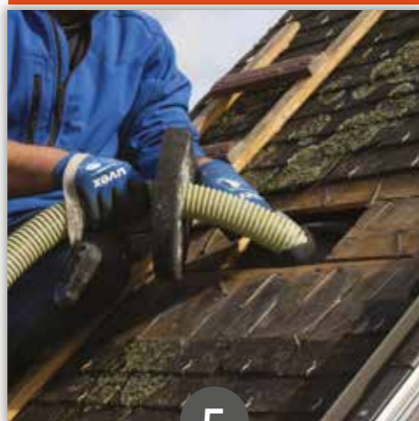
INSUFFLATION À HAUTE DENSITÉ D'ISOLANT EN VRAC
