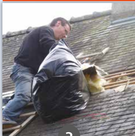
ENLÈVEMENT DE L'ANCIEN ISOLANT
